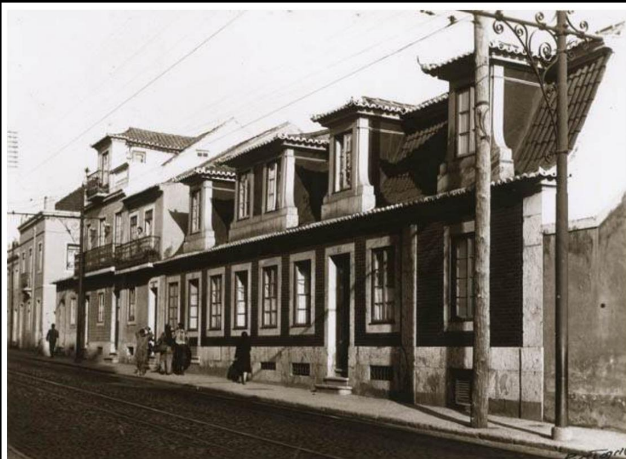
Fachada principal do edifício em análise, a partir da Rua da Junqueira, entre 1900 e 1958 (Eduardo Portugal, Arquivo Fotográfico de Lisboa, CML).
