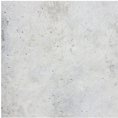
PAREDES EM BETÃO À VISTA COM VERNIZ, DE PROTEÇÃO, DENTRO DA CAIXA DE ESCADAS E NO PARQUE DE ESTACIONAMENTO
