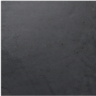
PAVIMENTO EM BETÃO COM ENDURECEDOR DE SUPERFÍCIE COM ACABAMENTO A HELICÓPTERO
