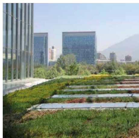
COBERTURA DO EDIFÍCIO VERDE ECOLÓGICO
